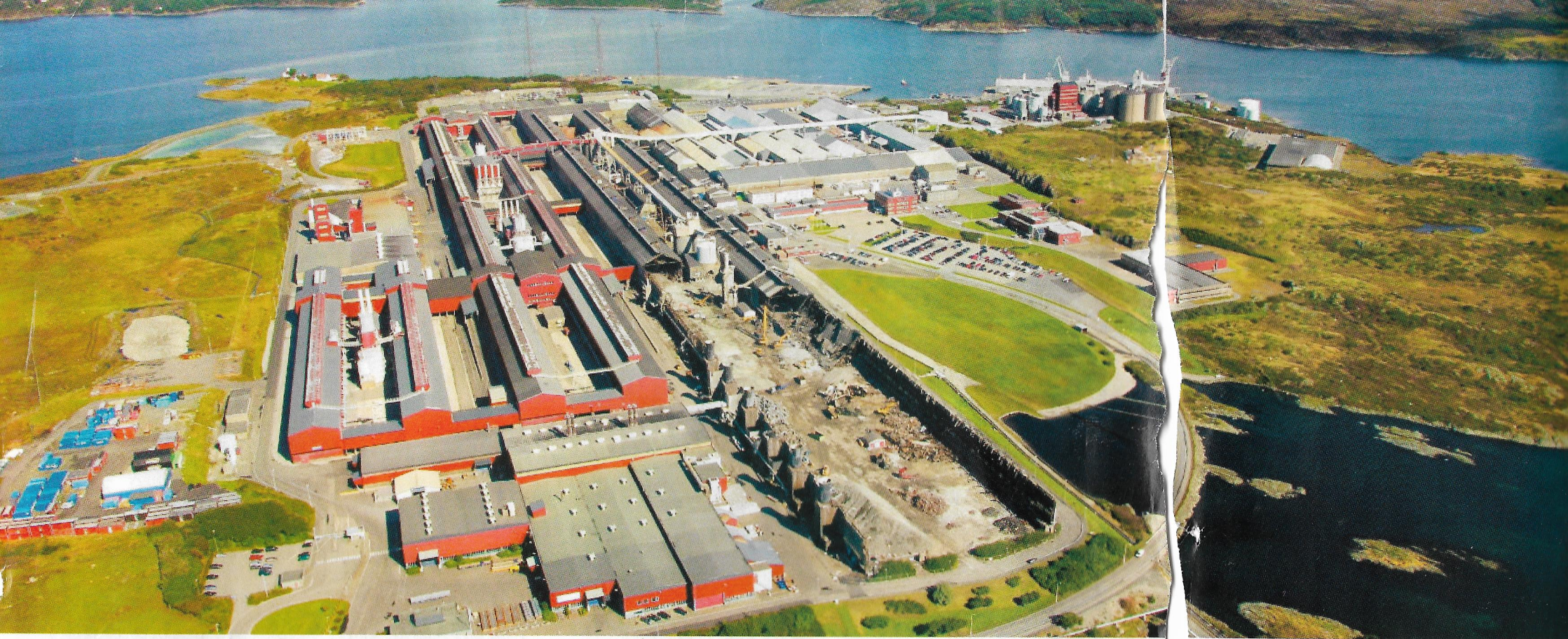
Flyfoto viser Hydro under rivingen av Sørderberg-hallene sett fra lufta. Bildet viser status for en tid siden. Nå er 75 % av hallene revet. (Foto: Hydro/Svein Morten Hagen)
